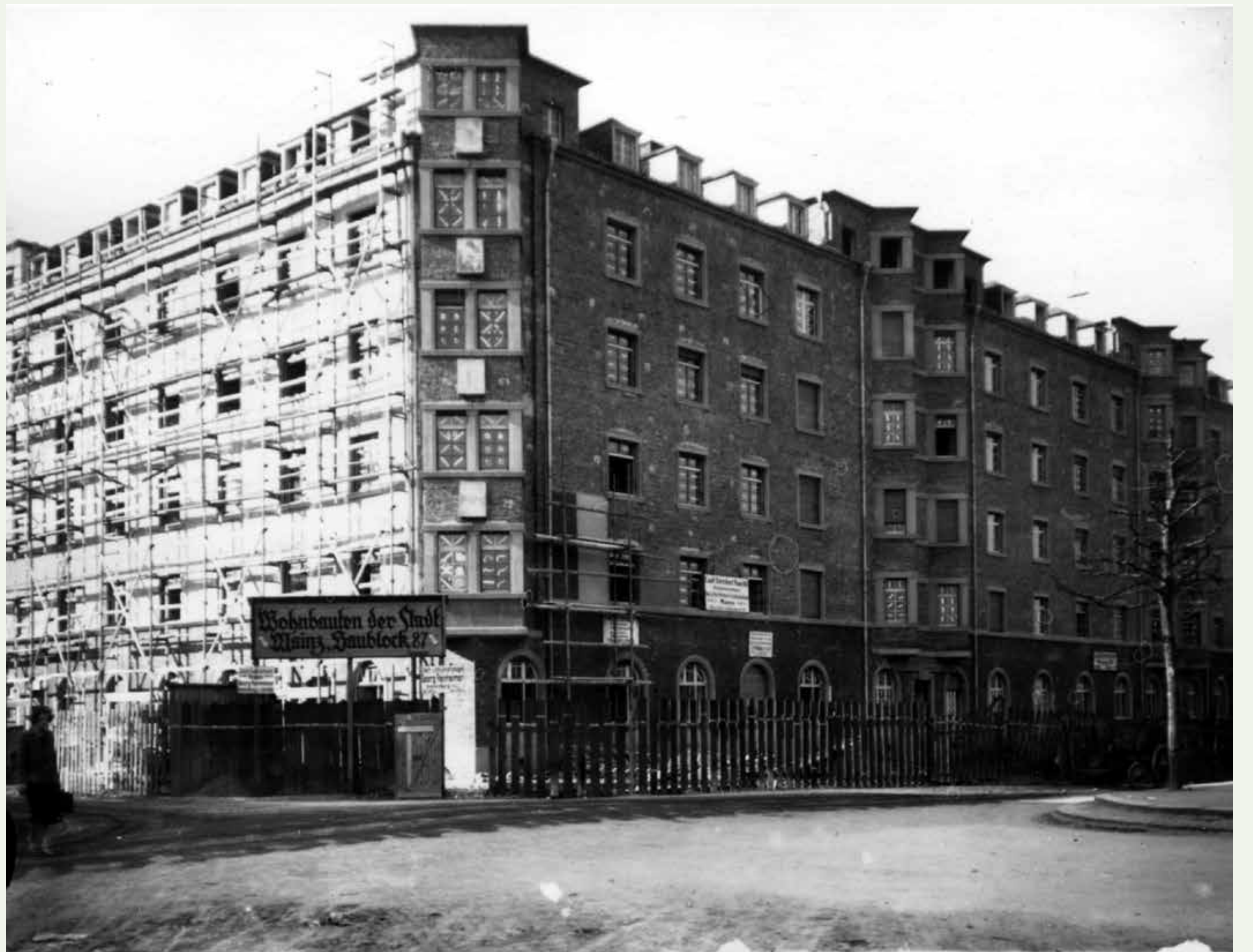
Rohbau der städtischen Wohnanlage an der Goethestr. 37, 1927. Sie wurde in der Presse als „modernste Wohnanlage Hessens“ gerühmt. (Stadtarchiv Mainz, BPSF 2418a)
