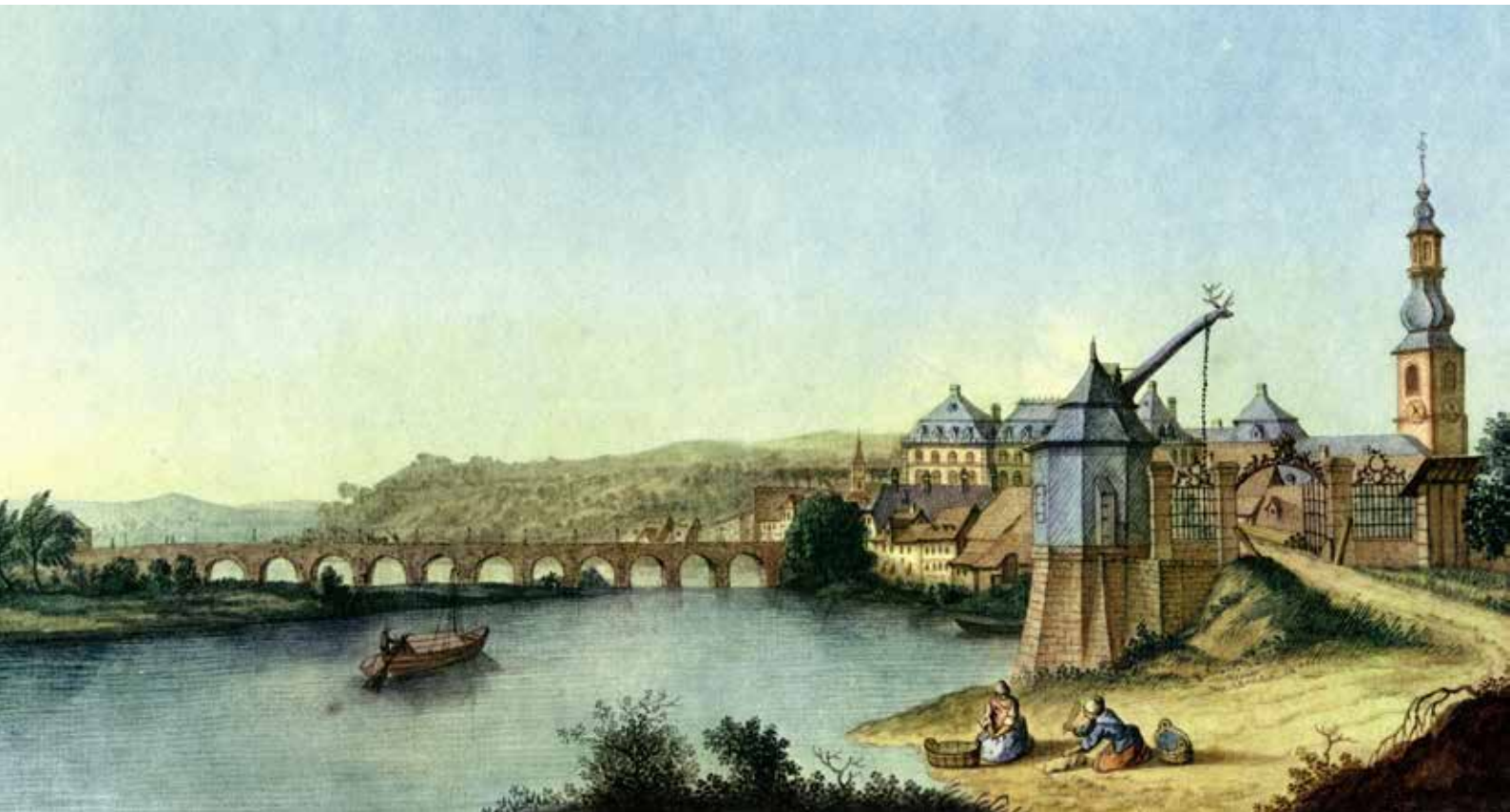
Die heutige „Alte Brücke“ wurde in den Jahren 1546/47 gebaut. Sie verband die Schwesterstädte Saarbrücken und St. Johann erstmals mit einem Bauwerk aus Stein. Auf dieser Brücke sollten nach der Pestordnung von 1574 die Wochenmärkte stattfinden. Foto: LA SB, B NL Hellwig 329.
